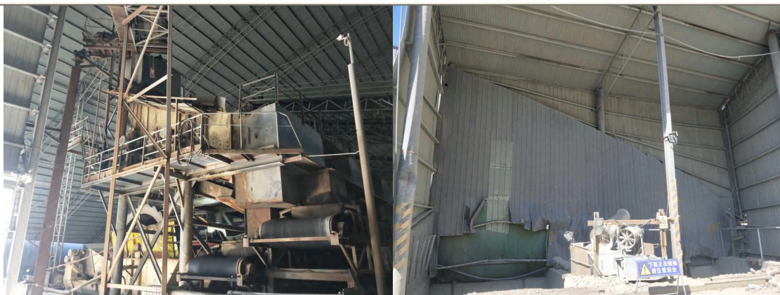
现场检测照片：
