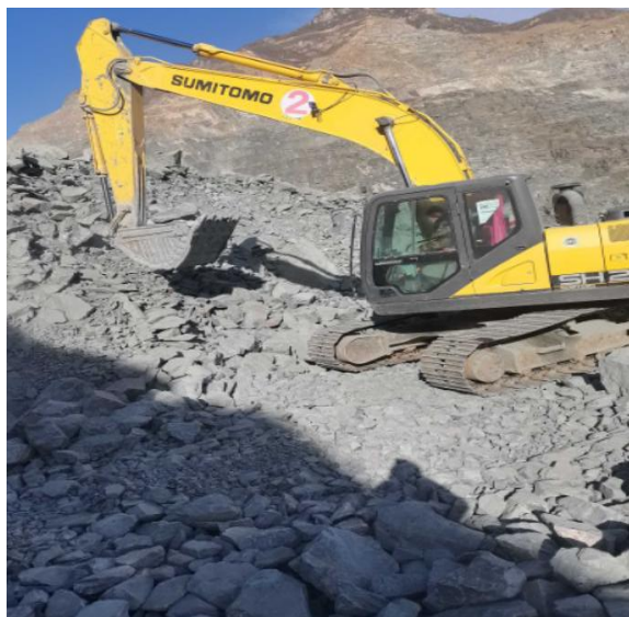
现场检测照片：
