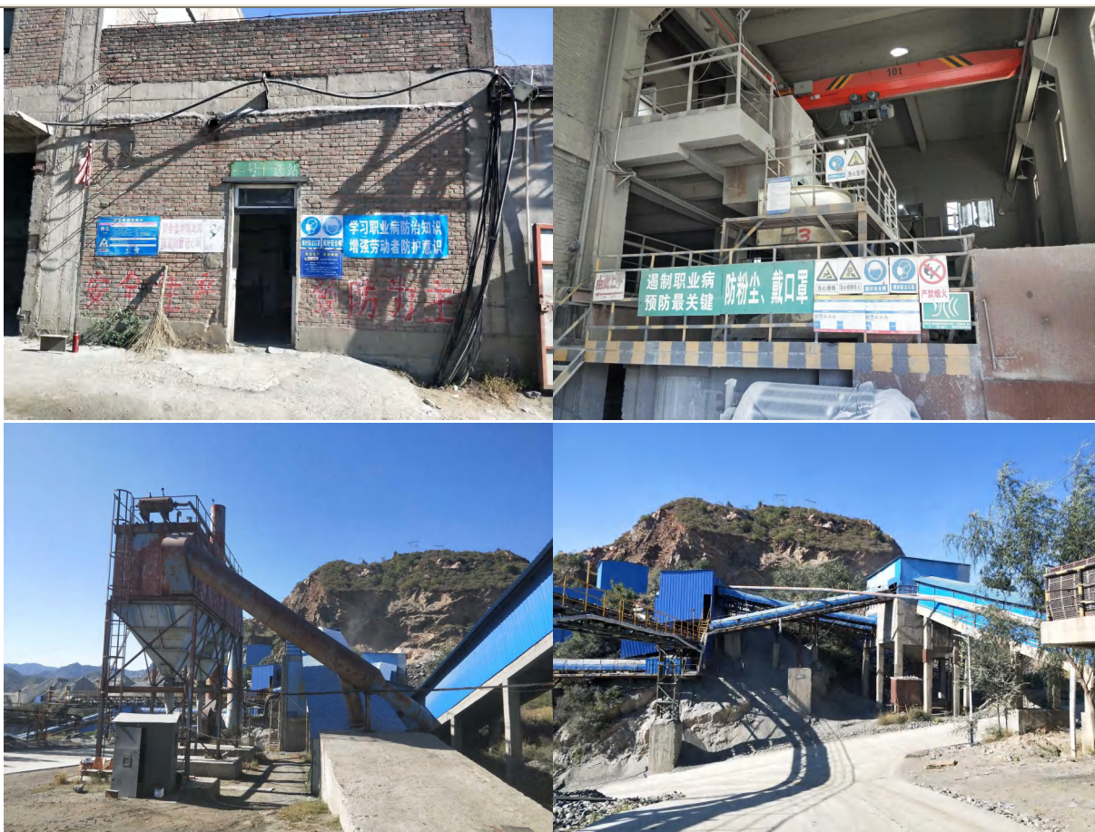
现场检测照片:
