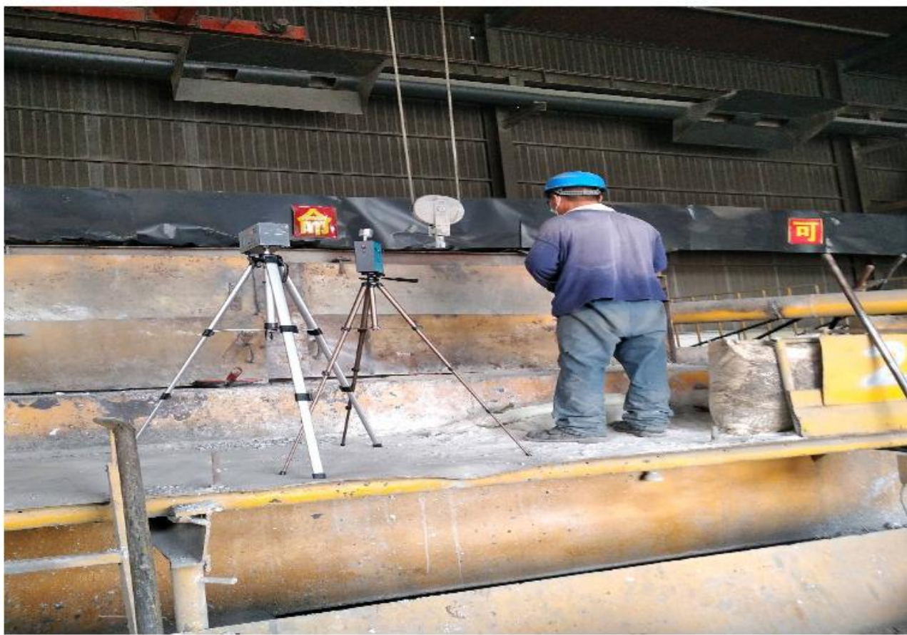
现场检测照片：
