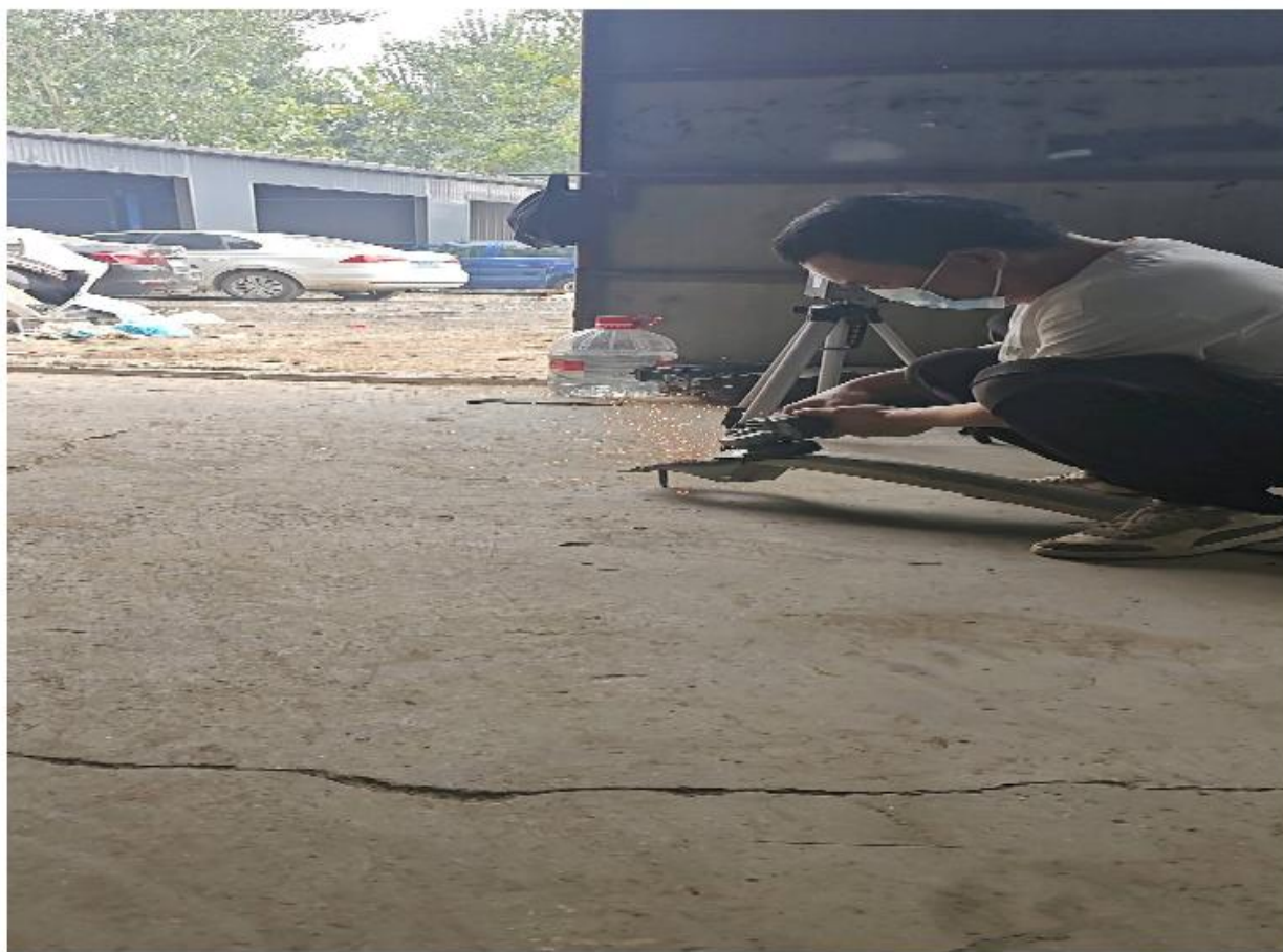
现场检测照片：
