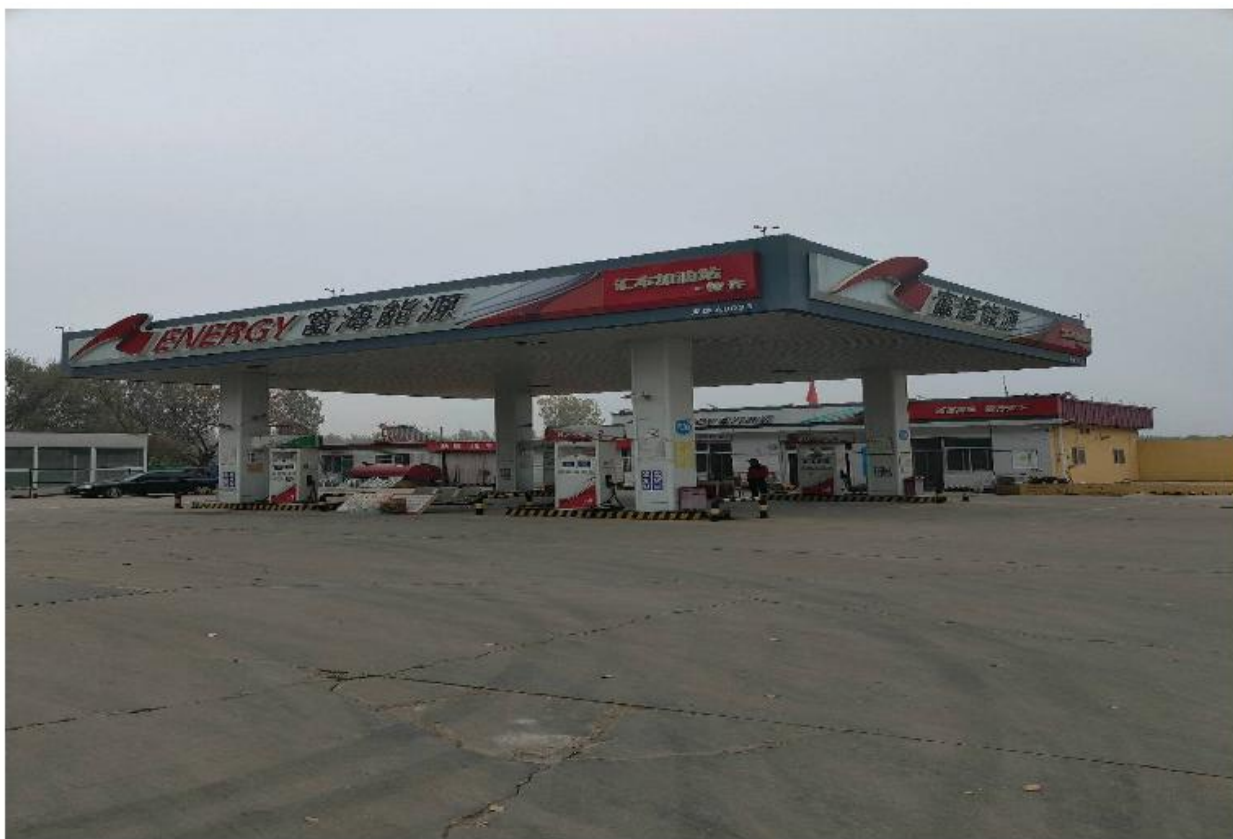
现场检测照片：
