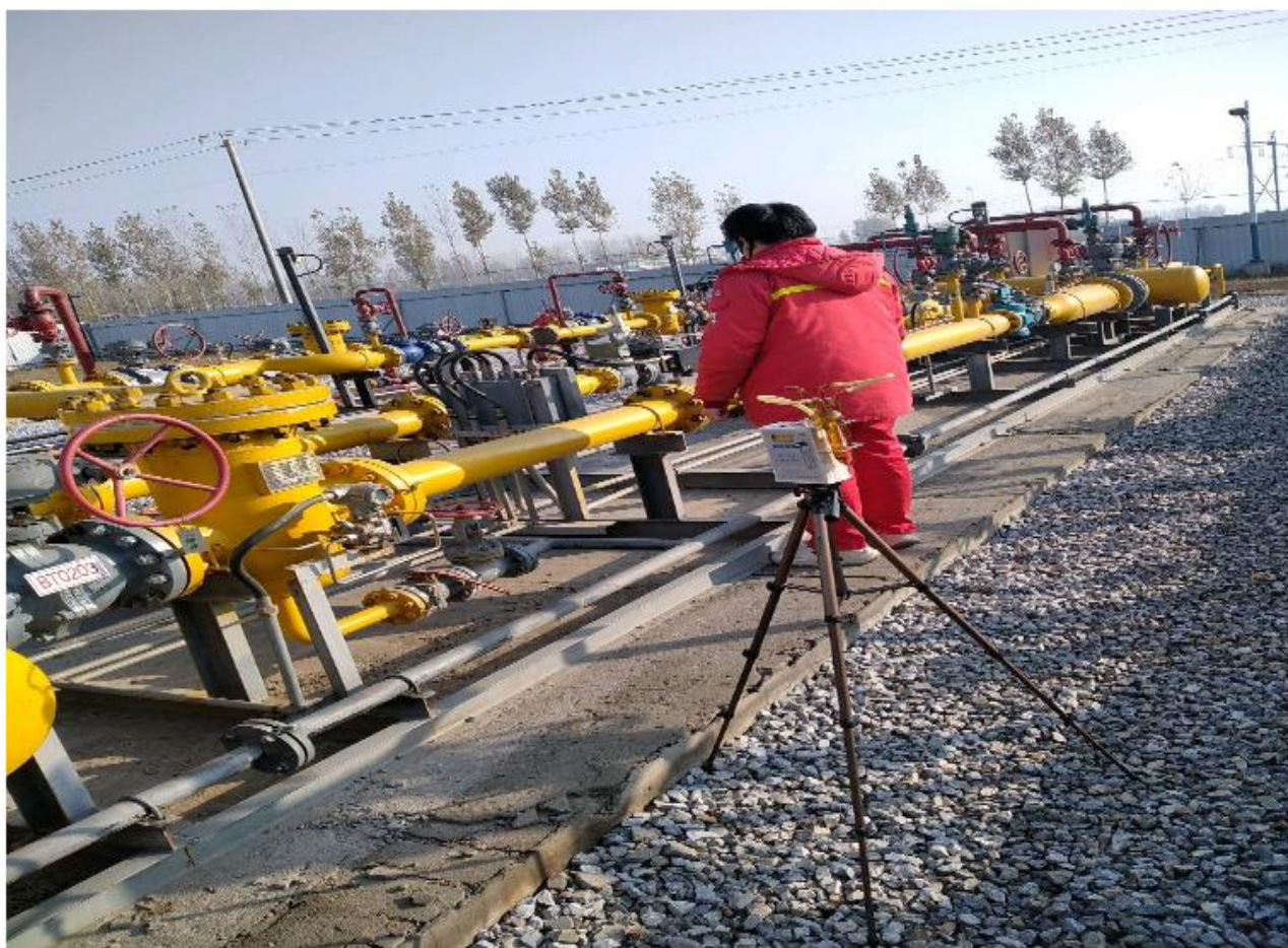
现场检测照片：
