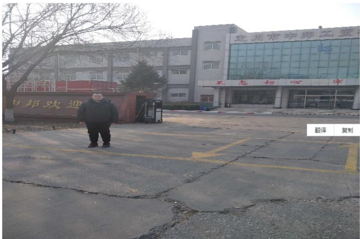
现场检测照片：
