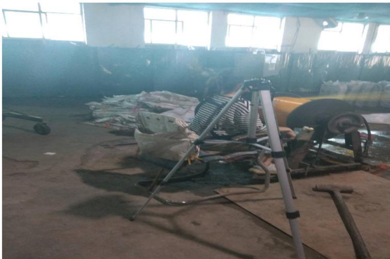
现场检测照片：
