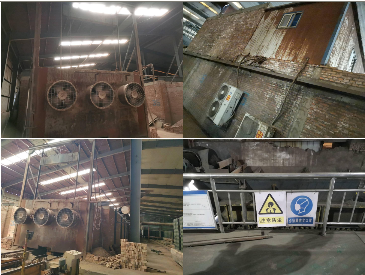
现场检测照片：
